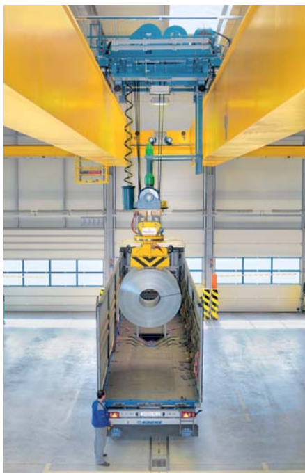
Halle 11: Coil-Entladung eines Lkw mit dem manuell bedienten Prozesskran und Lastmagnet
