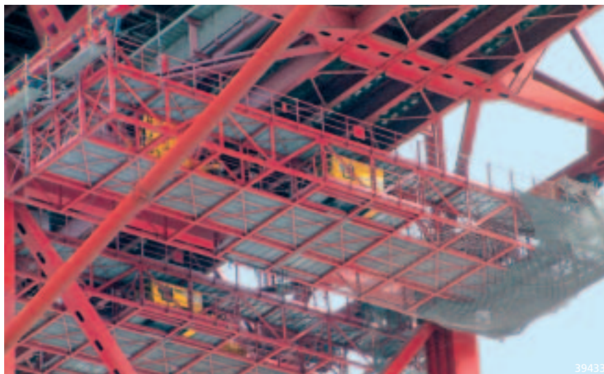
Титульный мотив: Переоснащение и модернизация шести платформ техобслуживания на мосте „Ponte 25 de Abril“ в Лиссабоне – была заменена полностью вся техника платформ и подобрана подвеска ходовой части
