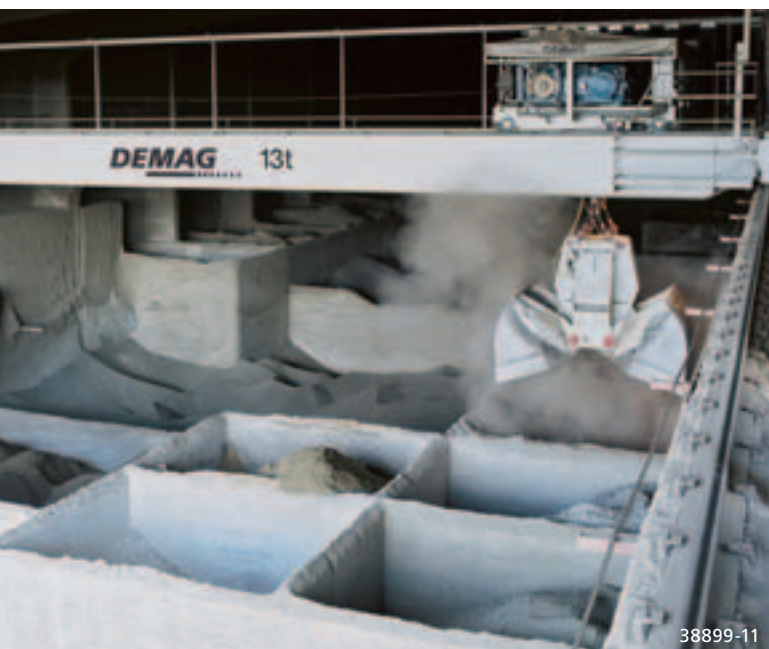
Автоматизированный процесс загрузки и выгрузки различных добавок, выполняемый автоматическим краном Demag на цементном заводе
