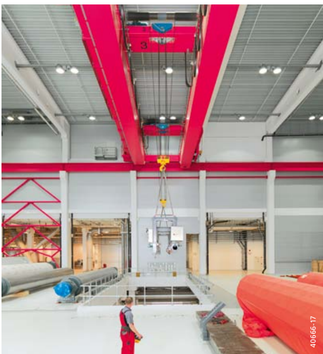
Lastenhandling über zwei Arbeitsebenen: Demag Kran in der Stoffaufbereitung
