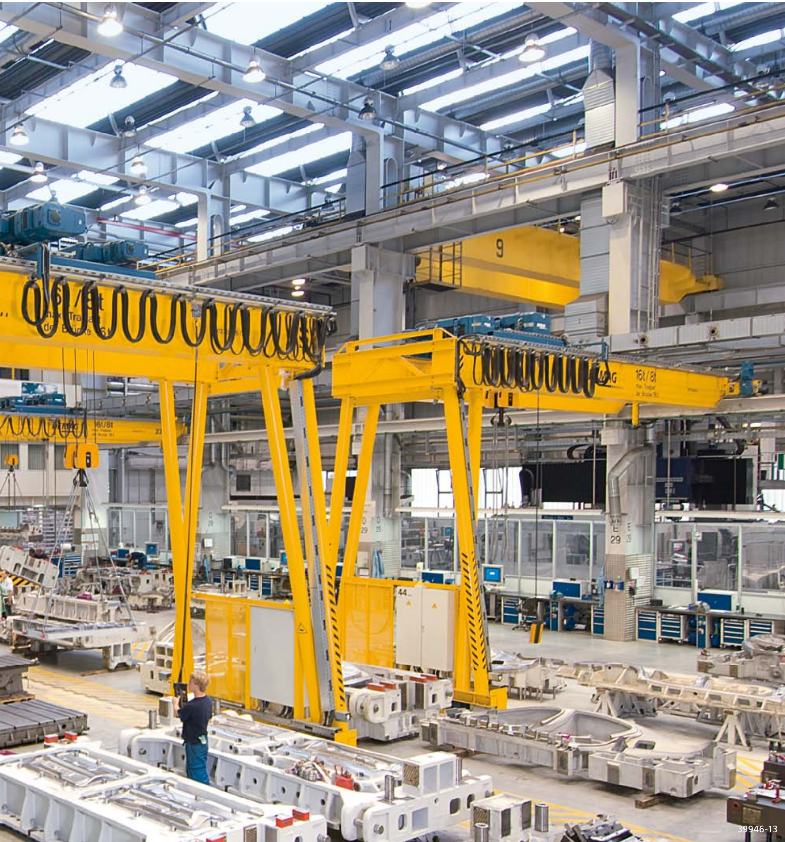
Zweiträger-Halbportalkrane für die Instandhaltung von Presswerkzeugen eines Automobilherstellers
