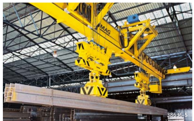
Synchronisation der Bewegungsabläufe zweier Hubwerke durch Master-Slave-Funktion
